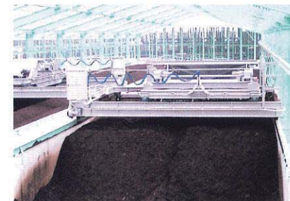
↑サークルコンポ NWZ70-23型 (切り返し機が後退しながらA槽に移動中)
