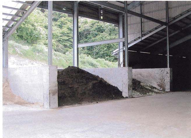
↑原料の受入槽(ダンプトラックで搬送します。)
